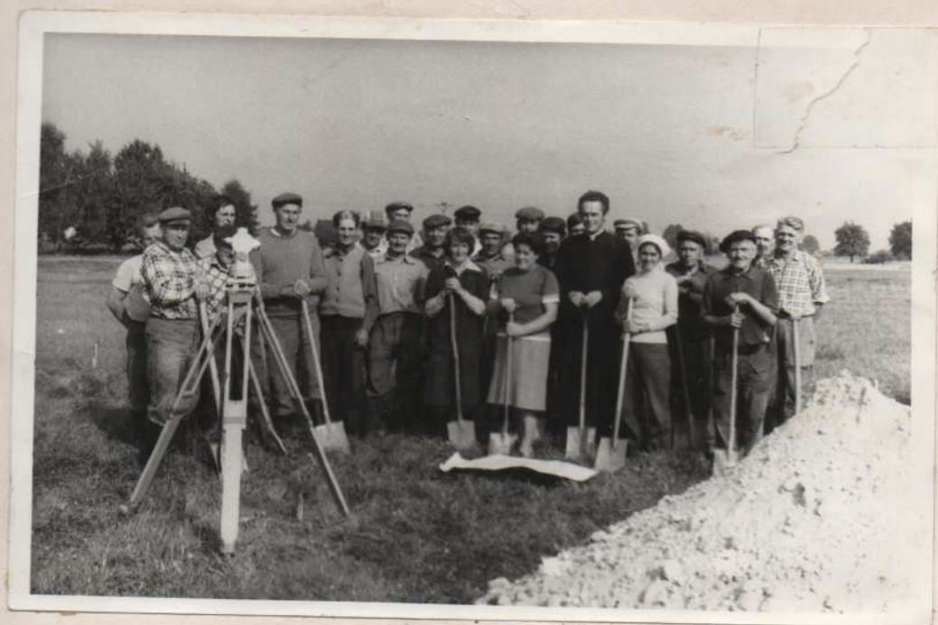
Parafianie ze swoim proboszczem z Topatami gotowi do kopania fundamentu pod swój długo oczekiwany kościół.
