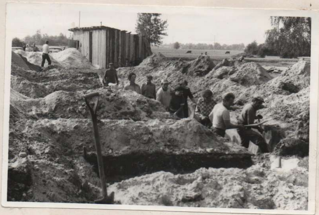
Kopanie fundamentów pod nową kościół.
